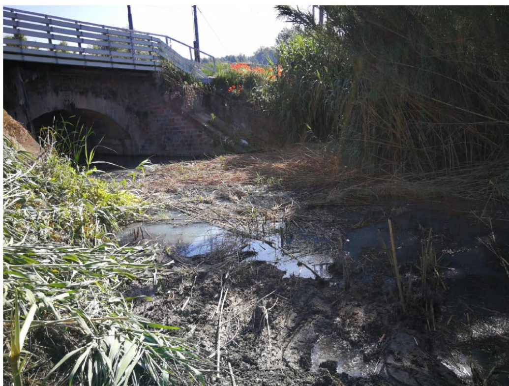
Figura 2 - sopralluogo nel sottopasso ferroviario lato sud del Piano di zona
