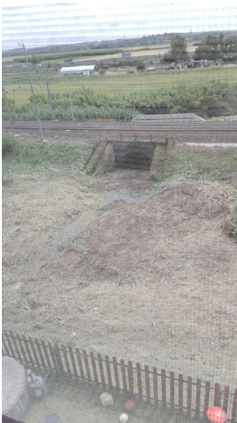
Figura 3 - sopralluogo nel sottopasso ferroviario lato nord del Piano di zona
